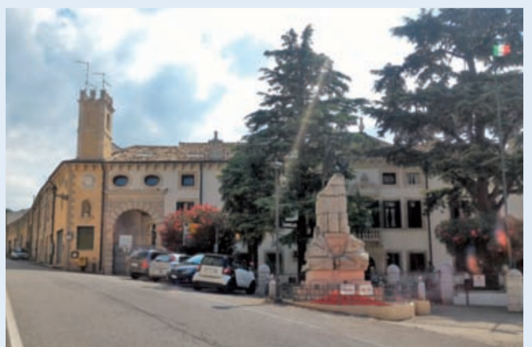
La casa di riposo. Alla sua sinistra gli edifici donati alla parrocchia
