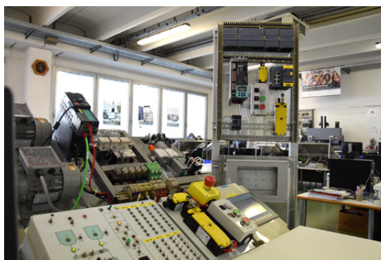
A sinistra, l'isola di lavoro del Laboratorio Safety Industriale. A destra, Nicola Gaole, docente dell'Istituto Salesiano San Zeno e coordinatore del settore elettrico ed energia
